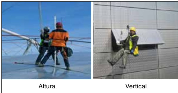
Figura 1. Ejemplo de trabajo en altura y vertical.
