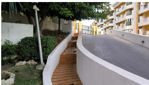
CAMINO ESTADO ACTUAL
