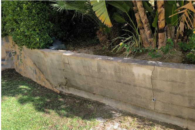
Muro de contención en jardinera. ESTADO ACTUAL
