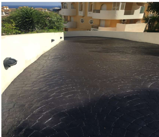
REPARADO Y ASFALTADO
